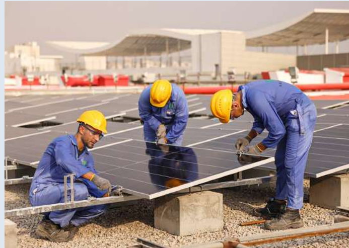
تركيب الألواح الشمسية ضمن توجه الشركة نحو استخدام الطاقة المتجددة
